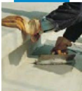
Shtrimi i Adesilex PG1 me shpatull te dhembzuar per vendosjen e strukturave te parafabrikuar
