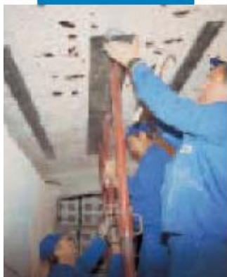
Venia ne pune e pllaka metalike per rforcimin e strukturave
